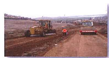
Foto N° 01: Vista en la que se observa los trabajos de nivelación y compactado de todo
