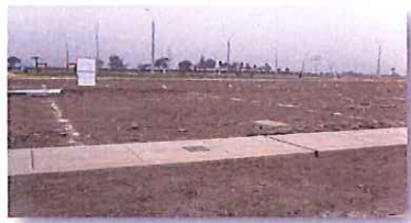
Foto N° 03: Vista en la que se aprecia la habilitación con servicios de agua, desagüe y veredas concluidas
