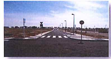
Foto N° 01: Vista en la que se aprecia la habilitación concluida
